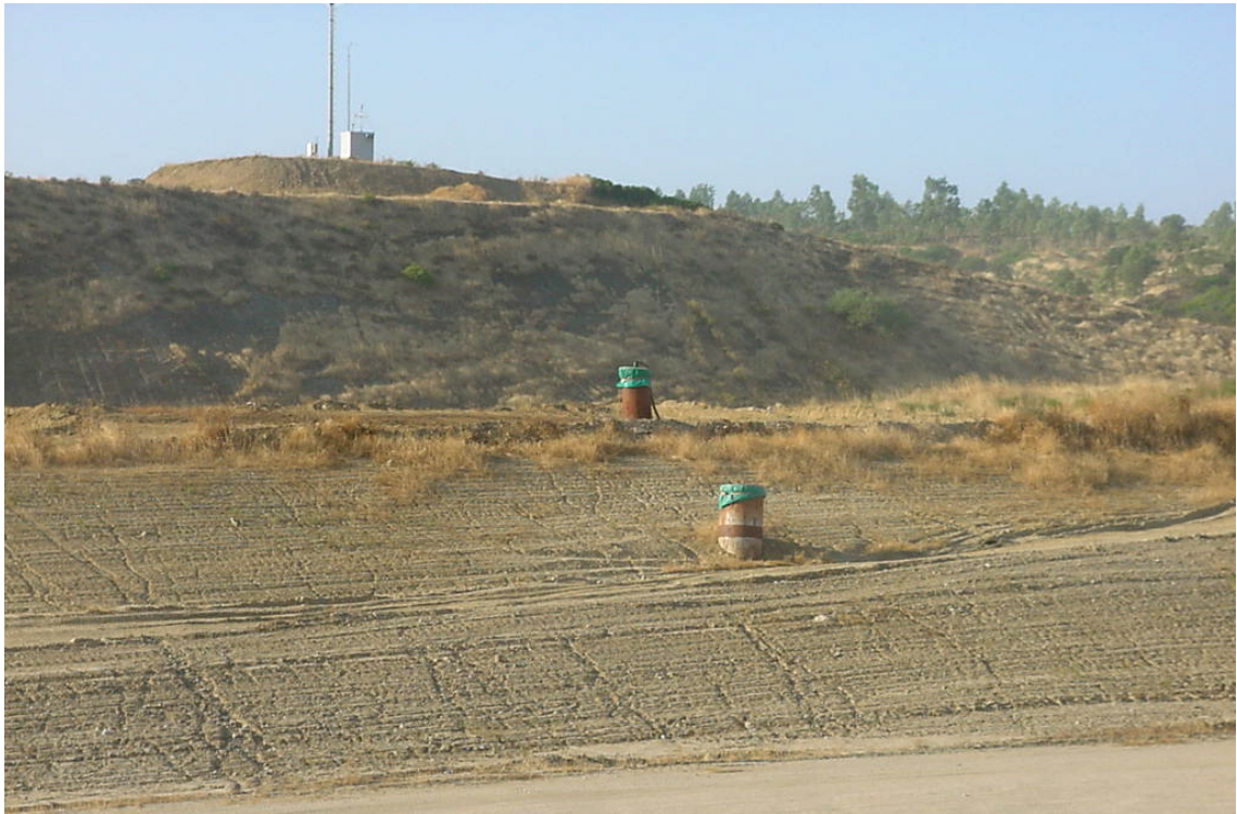
Foto 7: Vista da Nord del modulo per RSU dismesso e della scarpata naturale del versante, con particolare dei tubi di captazione del biogas
